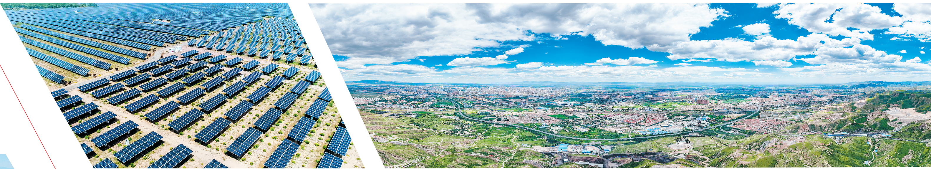
大同中电光伏发电有限公司聚光光伏电站
