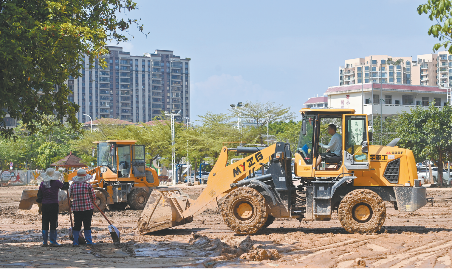
广西贵港:力争早日恢复生产生活秩序 七月十三日,工作人员在广西贵港市开展清淤作业。随着台风“美莎克”影响逐步消退,广西贵港市组织社会各方力量加紧开展排内涝、清淤泥和恢复供电等工作,力争早日恢复群众生产生活秩序。 新华社记者 陆波岸 摄
