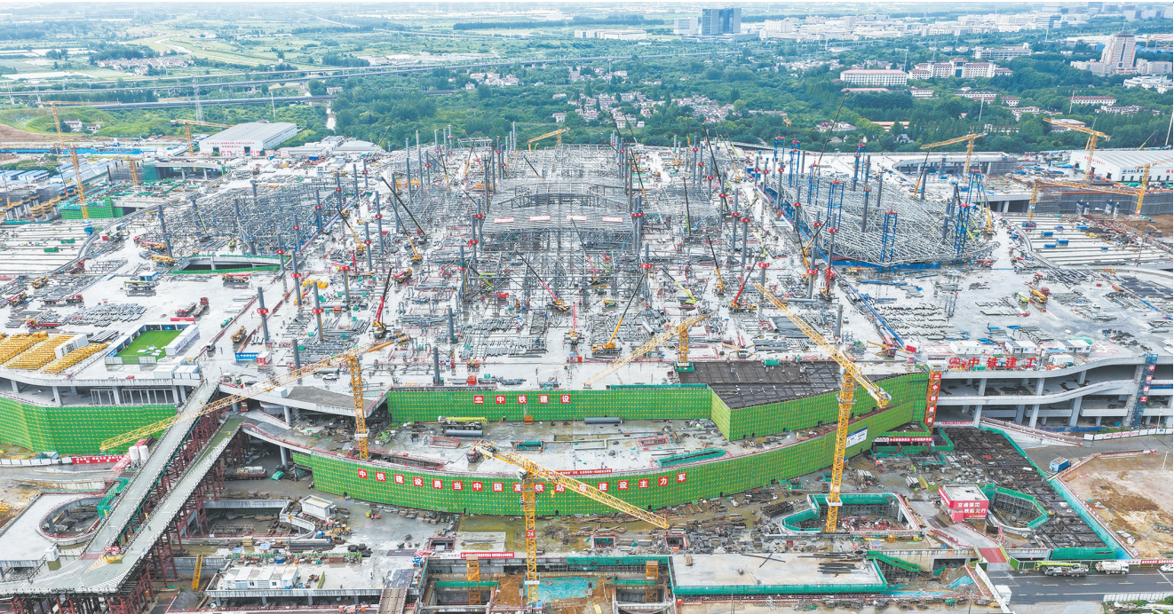
南京北站站房混凝土主体结构封顶 7月20日拍摄的南京北站建设现场（无人机照片）。7月20日，由中铁建设集团等单位承建的南京北站站房混凝土主体结构封顶，项目建设由土建结构施工转入屋面钢结构拼装、二次结构施工及装饰装修阶段。 据悉，南京北站总建筑面积约69.21万平方米，采用地上四层、地下两层的立体布局，站场规模为16台30线，是集高速铁路、城际铁路、普通铁路于一体的综合性铁路车站。南京站枢纽建设，将进一步完善南京铁路枢纽布局，对打造“轨道上的长三角”、推动长江经济带高质量发展、提升南京都市圈中心城市辐射能力等具有重要意义。 新华社记者 季春鹏摄
