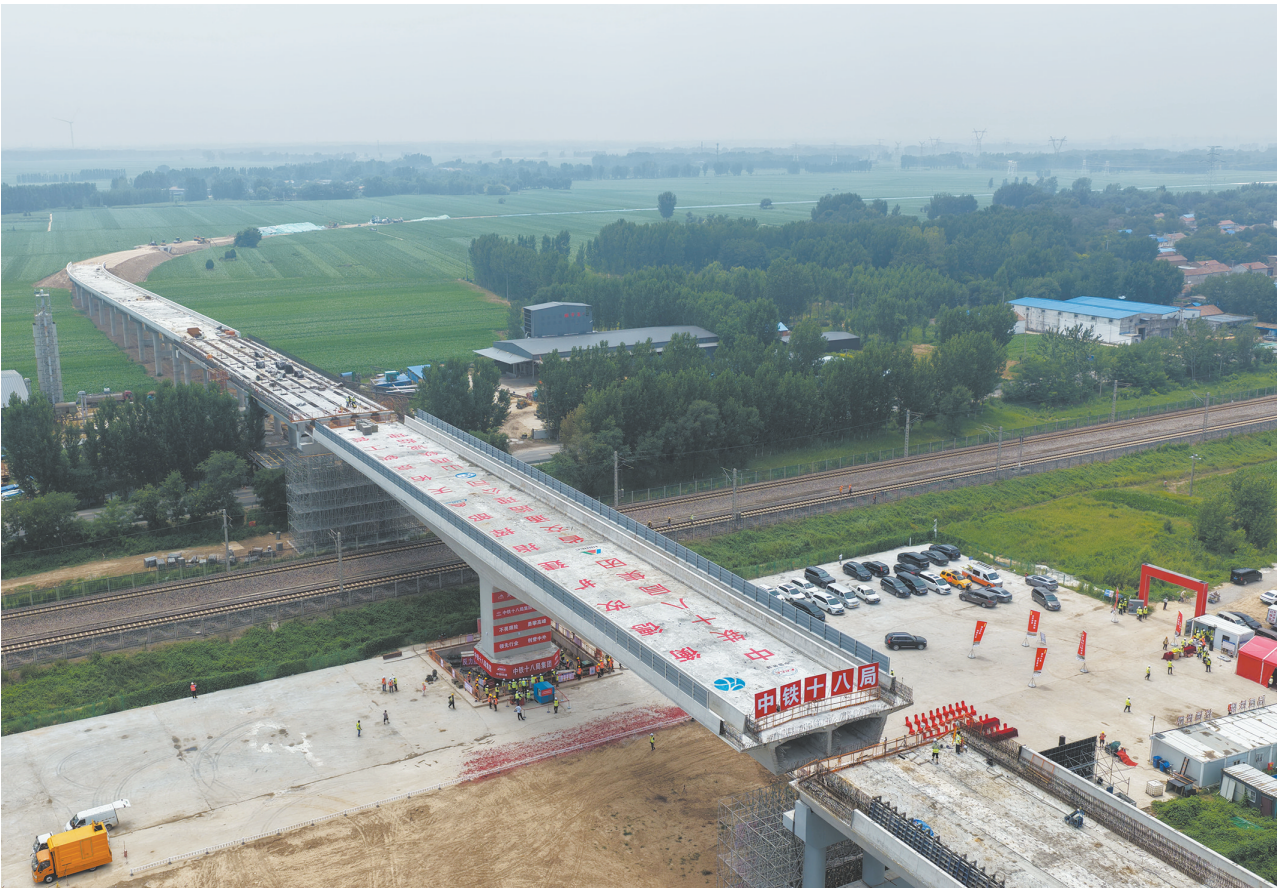
7 月 21 日拍摄的转体成功的衡德高速公路改扩建工程跨石德铁路转体桥（无人机照片）。
