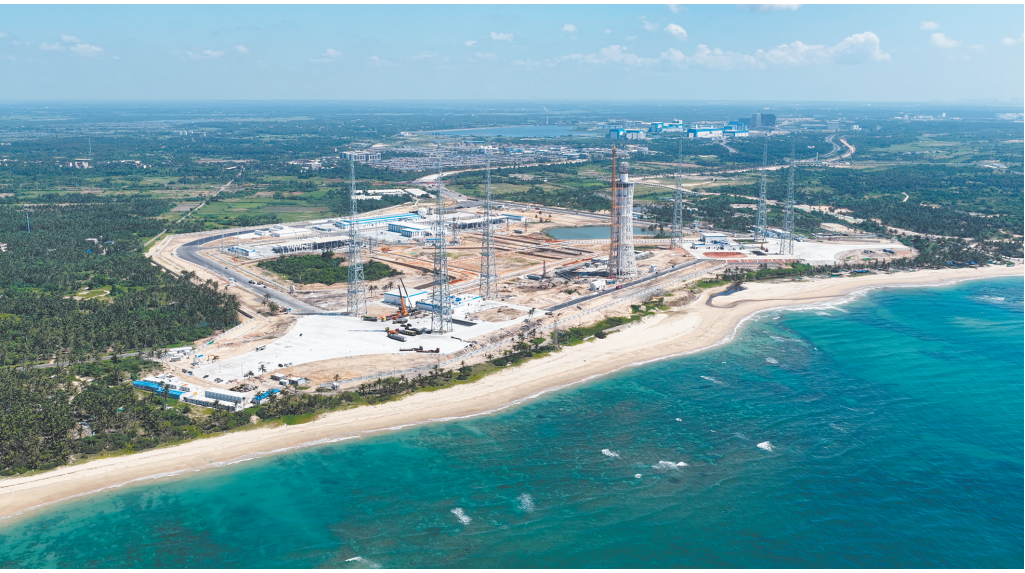
从空中俯瞰海南商业航天发射场二期发射区(7月24日摄,无人机照片)。 7月24日,海南商业航天发射场二期发射区土建工作完成,全面转入设备调试合练的关键阶段。海南商业航天发射场二期项目位于海南省文昌市东郊镇,于2025年1月25日正式开工,占地面积1100余亩,主要建设发射区、技术区等。 新华社发
