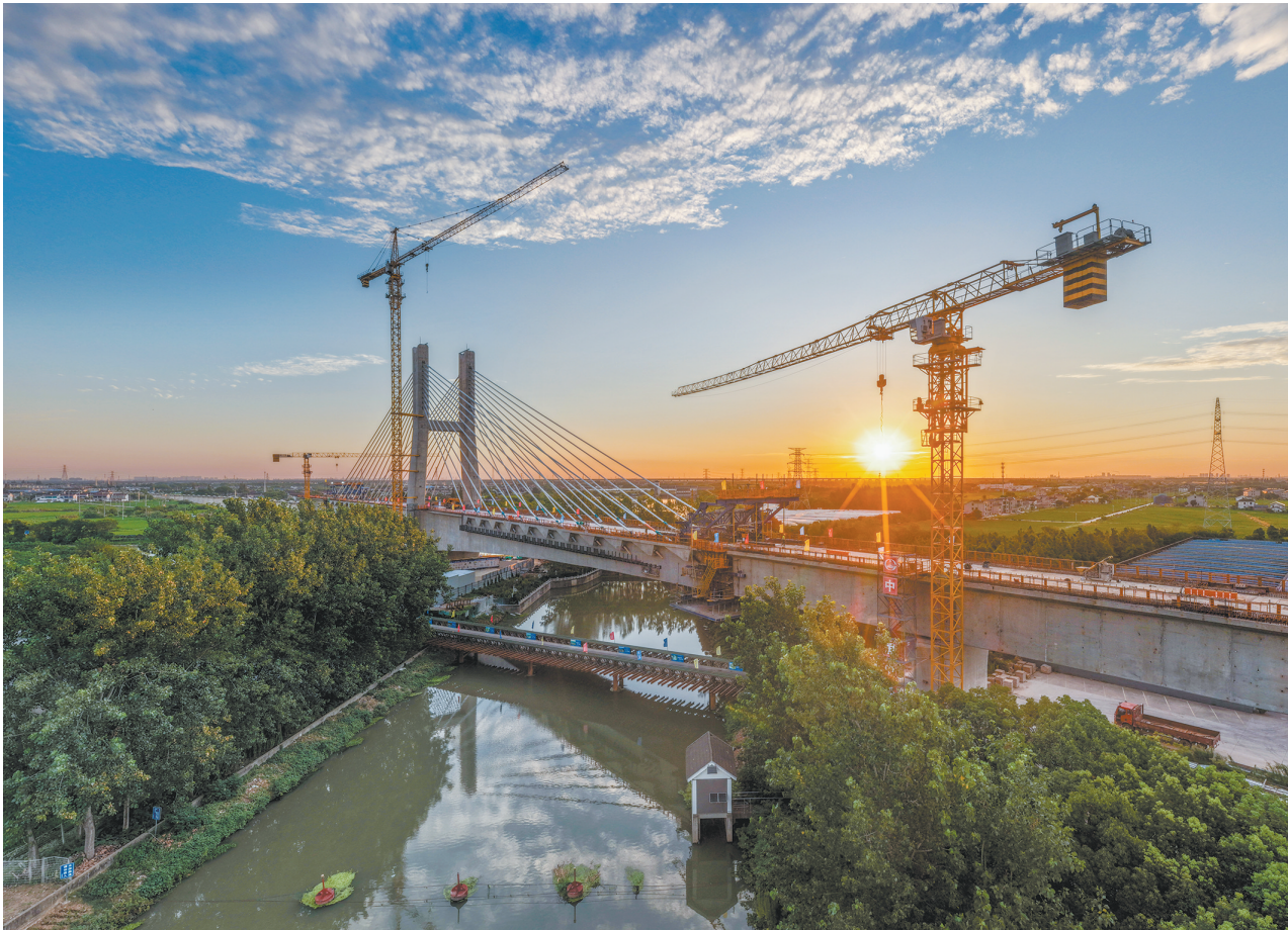
这是7月29日拍摄的通苏嘉甬高铁跨张家港河斜拉桥（无人机照片）。
