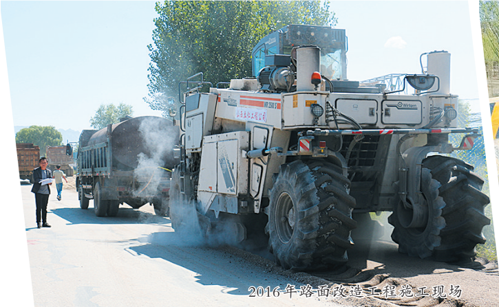
2016年路面改造工程施工现场
