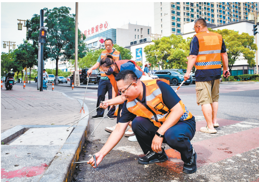
8月11日,平城区清远街道大齿社区党委联合环卫部门,对辖区雨水井、排水口开展全方位清掏疏通,打通排水堵点。图为社区、环卫工人正在清理辖区雨水井、排水口。 本报记者 韩壁璠
