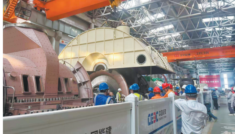
图为汽轮机扣缸作业现场。贾晓龙摄
