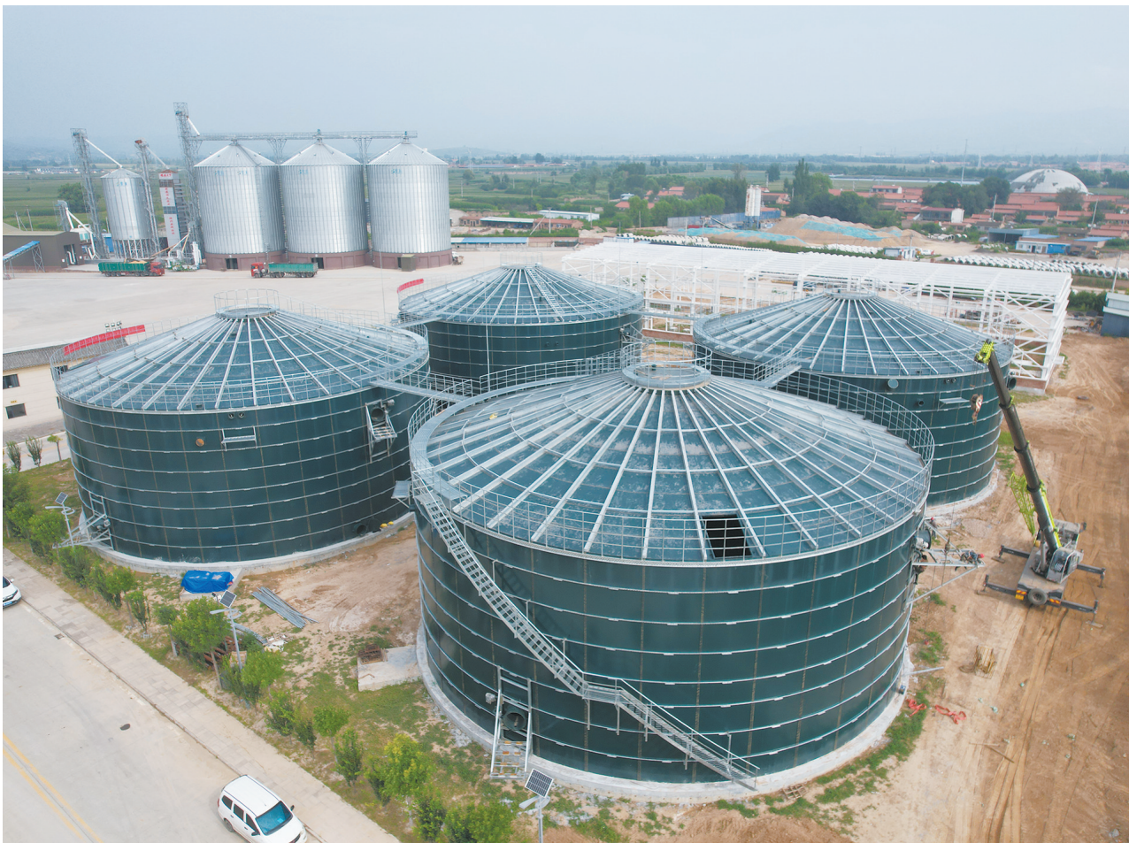
今年以来,为进一步提高农作物秸秆利用附加值,灵丘县实施秸秆综合利用项目。项目建成投产后,该县农作物秸秆综合利用利用率将达90%以上,显著改善农村人居环境,串起农民增收、企业增效、环境增色绿色产业链,为全县经济社会高质量发展注入强劲生态动能。图为灵丘县秸秆综合利用项目建设现场。
