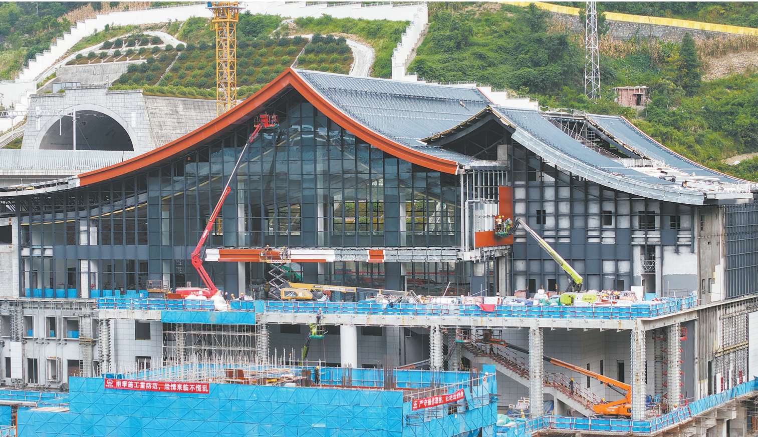
渝昆高铁昭通段车站建设进展顺利 八月十七日，工人在云南省昭通市盐津县境内的盐津南站施工（无人机照照片）。目前，渝昆高铁云贵站房一标项目正在加紧施工，多个车站工程进展顺利。渝（重庆）昆（昆明）高铁是国家八纵八横高铁网的重要组成部分，设计行车时速三百五十公里。 新华社发（梁志强摄）
