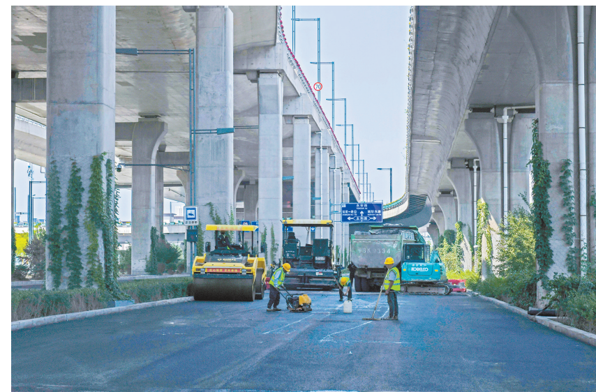
8月20日,市城管局施工人员在开源街大同南站路段进行沥青摊铺作业。施工现场,摊铺机、压路机有序作业,修补破损路面,平整道路基层。此次道路养护旨在修补路面病害,改善大同南站周边通行条件,提升路网运行质量,保障过往车辆顺畅通行。本报记者 于宏摄
