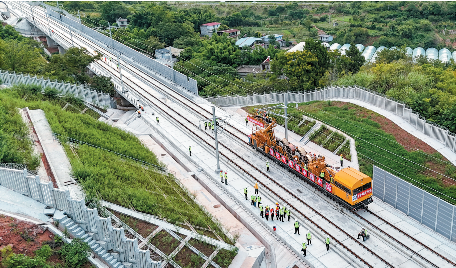
成渝中线高铁全线首条接触网导线成功架设 这是八月二十日在成都至重庆高速铁路简州至乐至区间拍摄的接触网导线架设作业现场(无人机照片)。 八月二十一日,由中国中铁电气化局集团承建的成渝中线高铁全线首条接触网导线成功架设,标志着成渝中线高铁“四电”工程正式进入攻坚阶段。 成渝中线高铁是我国八纵八横高铁网沿江通道的重要组成部分,正线全长二百九十二公里,设计时速三百五十公里。 新华社发(马博摄)
