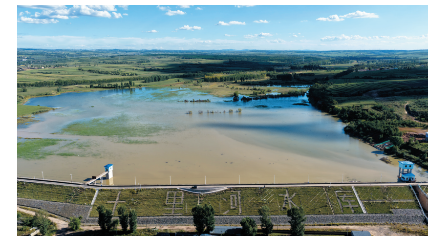
万家寨引黄北干支线工程主体完工,顺利实现向左云县通水目标。高晓忠摄
