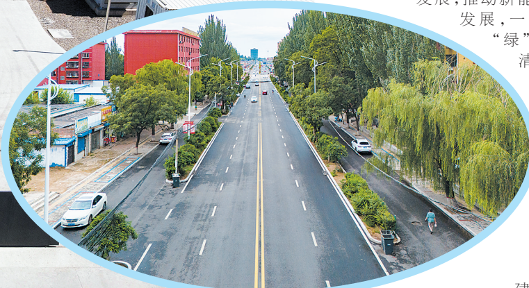
云冈区平泉路路面改造工程顺利完成。
