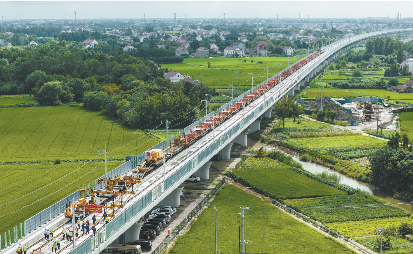
沪渝蓉高铁 沪宁段铺轨启动
