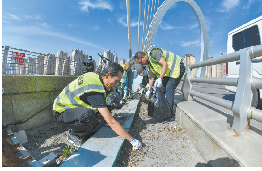
9月16日,市城市桥涵设施服务所工作人员在南环桥清除杂草。当日起,市城市桥涵设施服务所组织干部职工,对御河7座大桥开展环境整治专项行动,重点对桥面、下穿通道开展垃圾捡拾、便道维护、杂草清除等作业,多措并举筑牢桥梁安全防线,持续改善市民通行环境。 本报记者 于宏振
