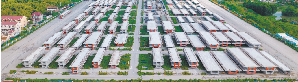
空中俯瞰中铁四局宝惠制梁场(9月22日摄，无人机照片)。
