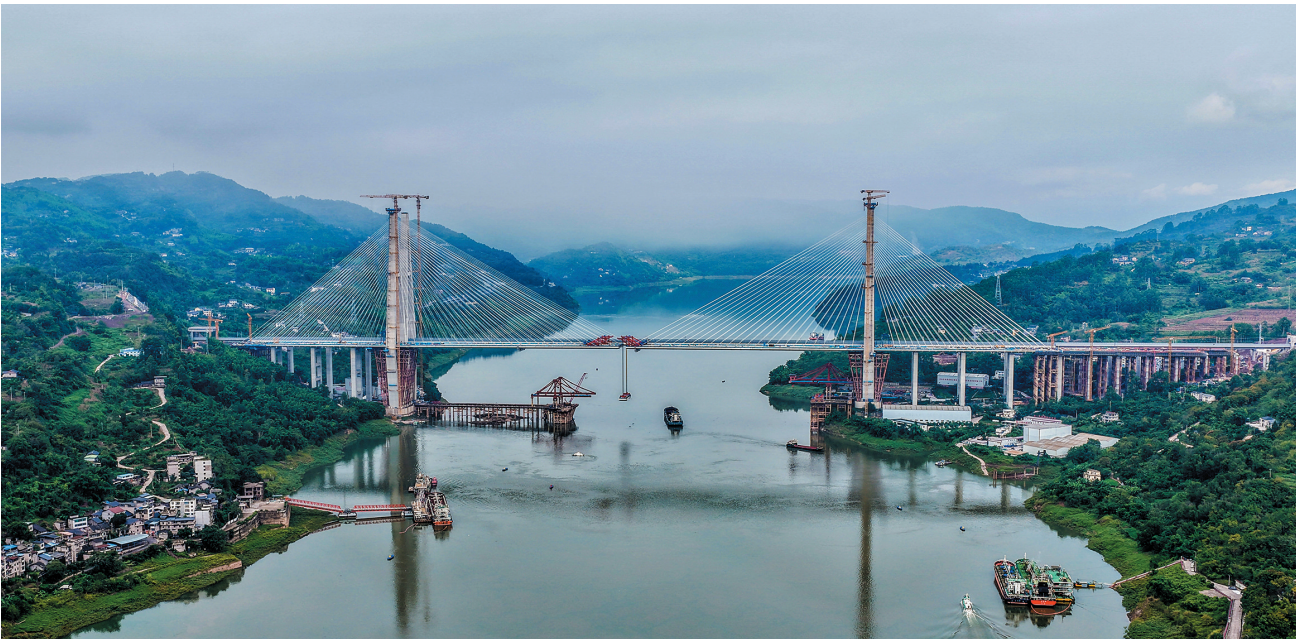
这是9月24日拍摄的渝万高铁石沱长江大桥全桥合龙现场(无人机照片)。9月26日,由中铁大桥局承建的渝万高铁控制性工程石沱长江大桥公路桥完成钢梁吊装实现合龙,至此大桥铁路、公路部分全部合龙,为后续桥面铺装及附属工程施工,保障渝万高铁按期建设打下坚实基础。
