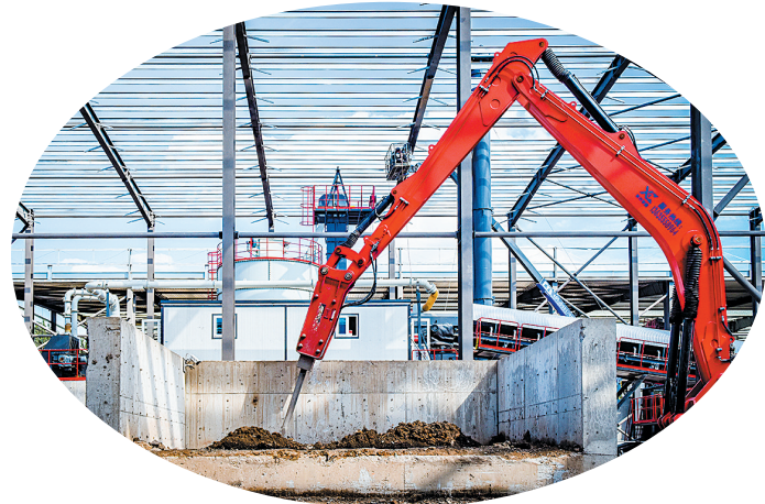
在大同市富凯鸿新型建材科技有限公司，机器正在破碎建筑垃圾。
