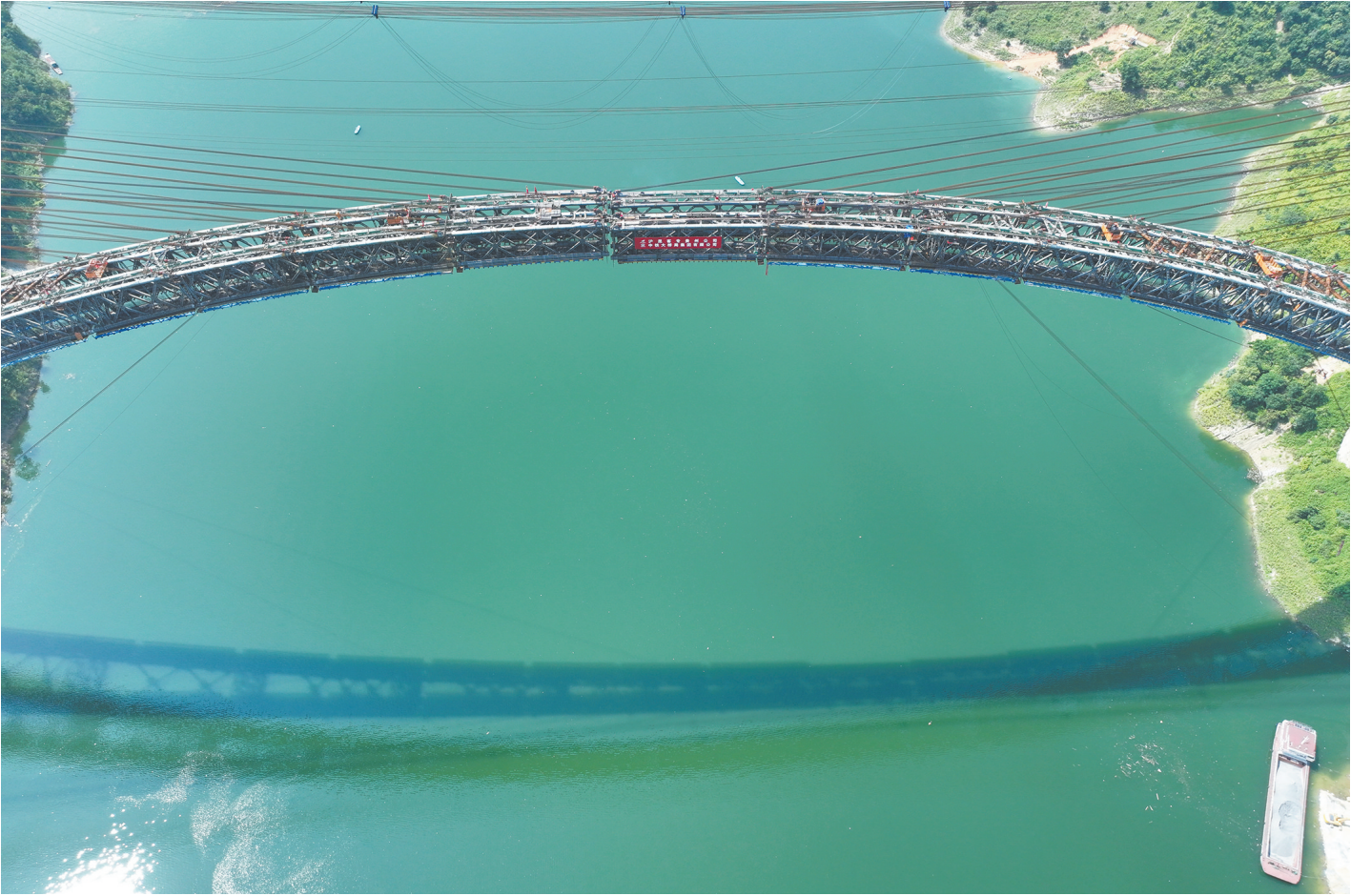
这是9月24日拍摄的即将完成主拱肋合龙的黄百铁路红水河大桥(无人机照片)。
