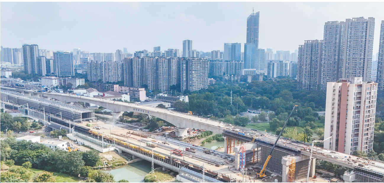
这是10月13日拍摄的成渝中线高铁跨沙河特大桥合龙施工现场(无人机照片)。
