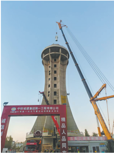
图为雷达吊装现场。申力摄
