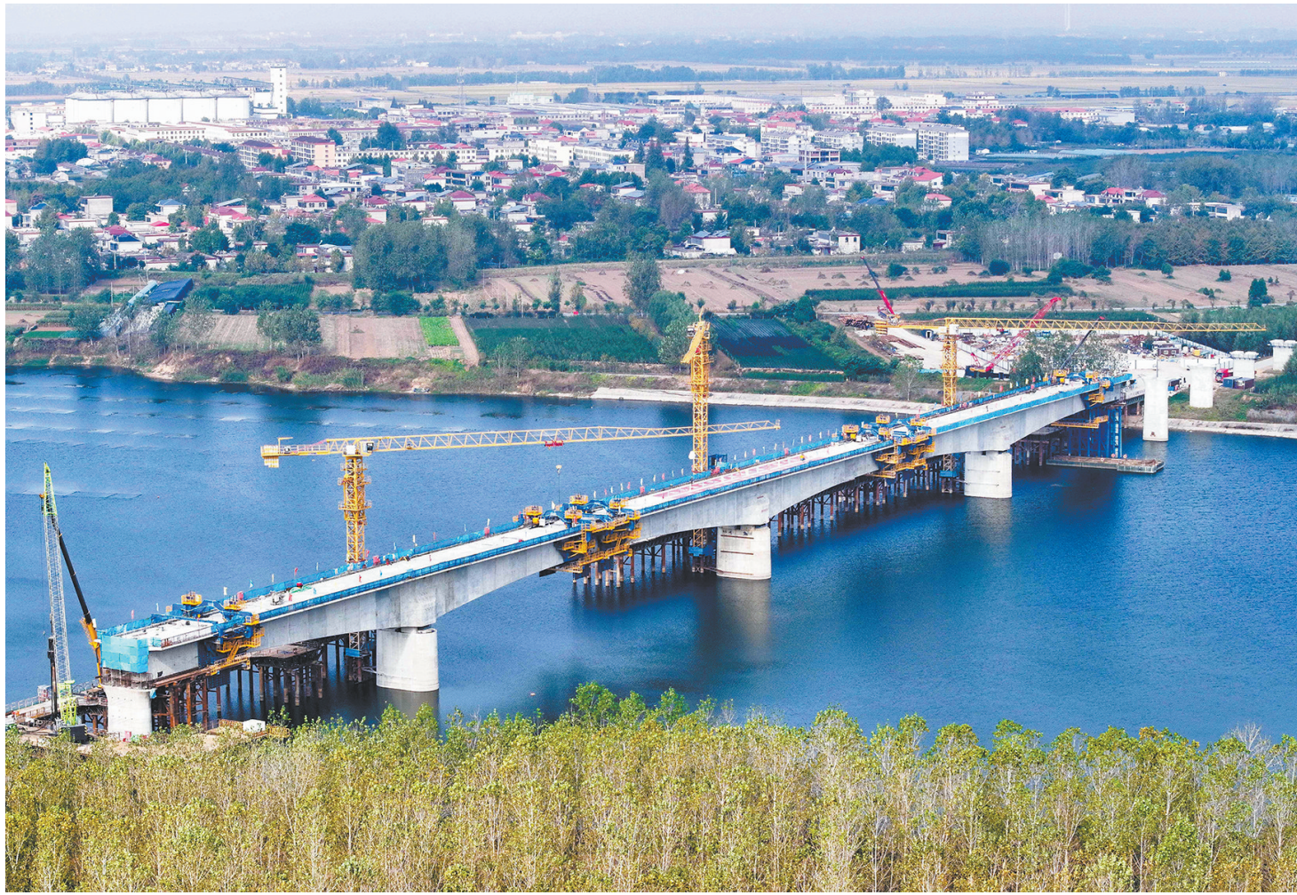
这是十月十六日拍摄的合龙后的淮宿高铁跨沭河连续梁（无人机照片）。十月十五日，国家重点工程（场）宿迁（淮）高铁跨沭河连续梁顺利合龙。该工程由中铁上海局承建，为后续无砟轨道施工、全线按期贯通打下坚实基础。淮宿高铁是京沪高铁辅助通道重要组成部分，将便利沂蒙山与苏北革命老区群众出行，助力区域经济发展。
