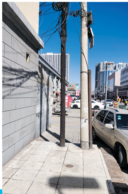
加固后电杆附近变得干净整洁 龙中华 摄
