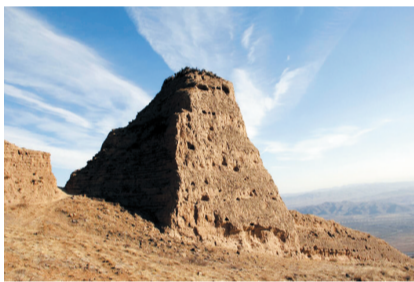
李二口骑墙墩,体量巨大,底宽近14米,残高13米。
