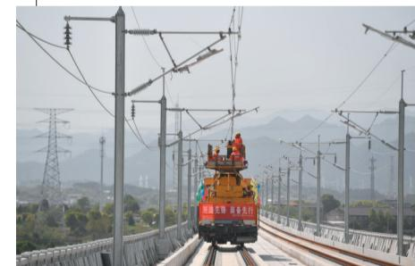
4月18日，施工人员在杭绍台铁路上进行接触网导线架设作业。
