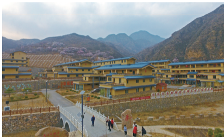
灵丘县龙渠沟有机社区
