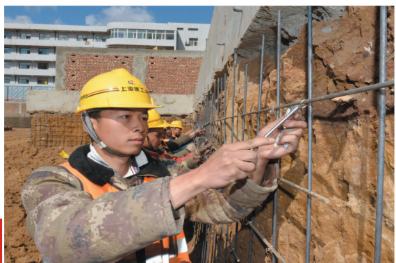
市三医院新建医技、急诊楼项目施工现场,河南小伙李鹏举在绑扎钢筋。
