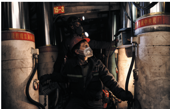
晋能控股煤业集团铁峰煤业公司综采队工人孟玺平在井下工作面操作综采机组。
