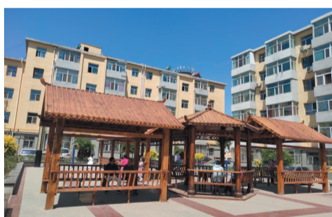
建设里小区新建的凉亭
