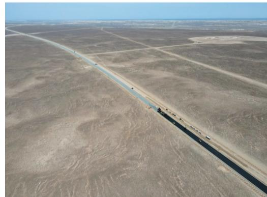
工人驾驶机械在阿乌高速二期工程施工现场进行沥青摊铺（7月16日摄，无人机照片）。
