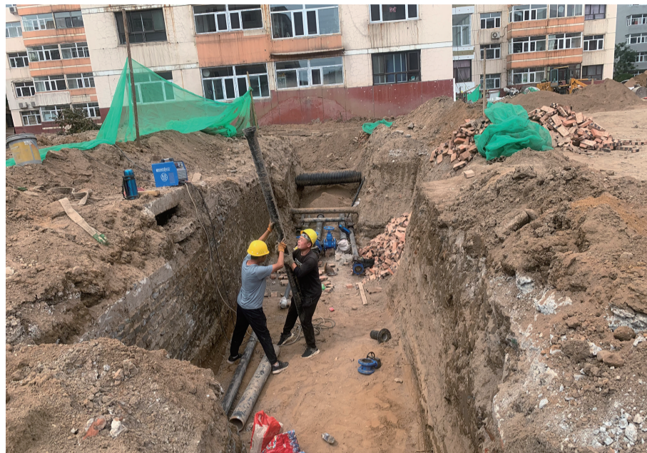
云龙苑小区更换自来水管网
