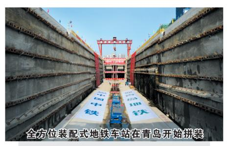
10月29日,施工人员在青岛地铁6号线可洛石站施工。 当日,全方位装配式地铁车站在青岛地铁6号线可洛石站开始拼
