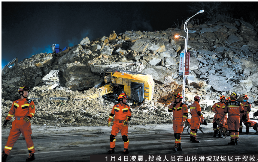
1月4日凌晨,搜救人员在山体滑坡现场展开搜救。
