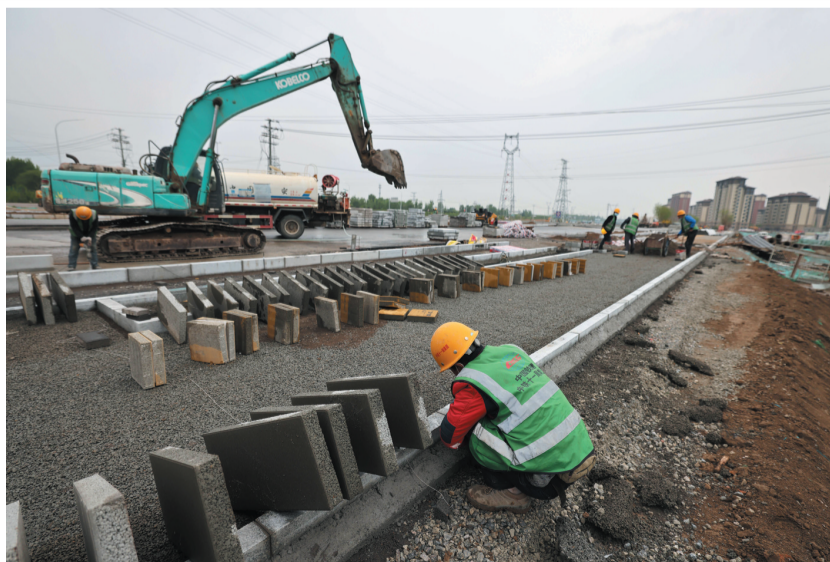
4月28日，中铁十一局的工人在雄安新区容西片区奥威路施工。奥威路总体呈东西走向，为雄安新区容西片区的城市主干路。目前工程进展顺利，已经接近尾声。 新华社发
