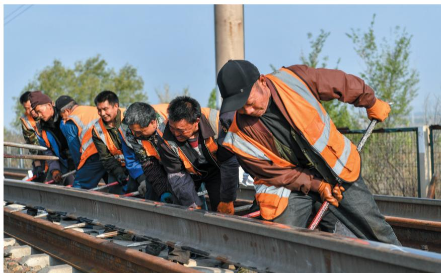
5月10日，中国铁路太原局集团有限公司大同工务段的工人在更换大秦铁路的钢轨。
