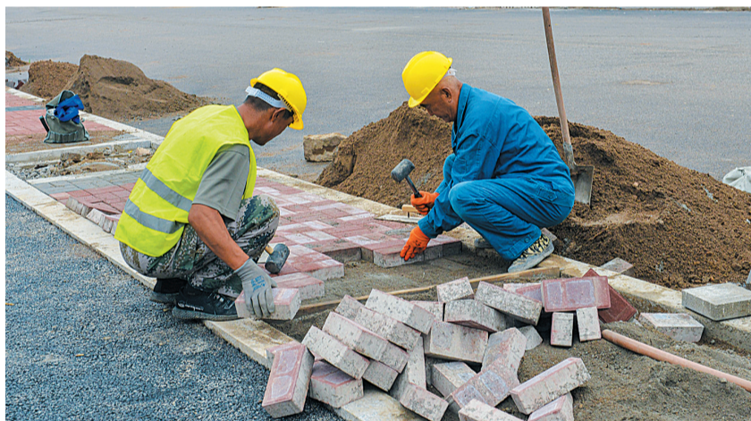
工人正在铺设便道砖
