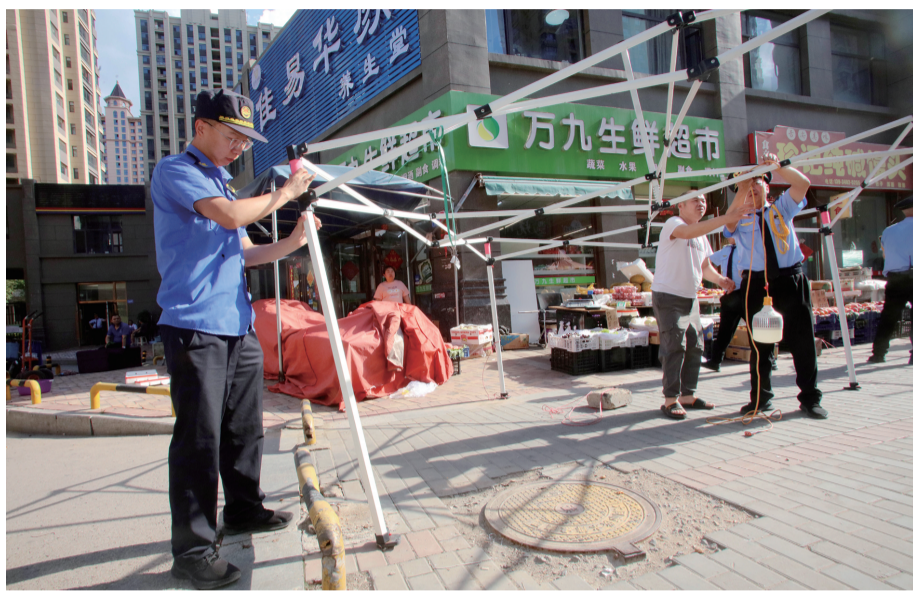
工作人员拆除商户私自搭建的棚、伞、架 本报记者 韩莹 摄
