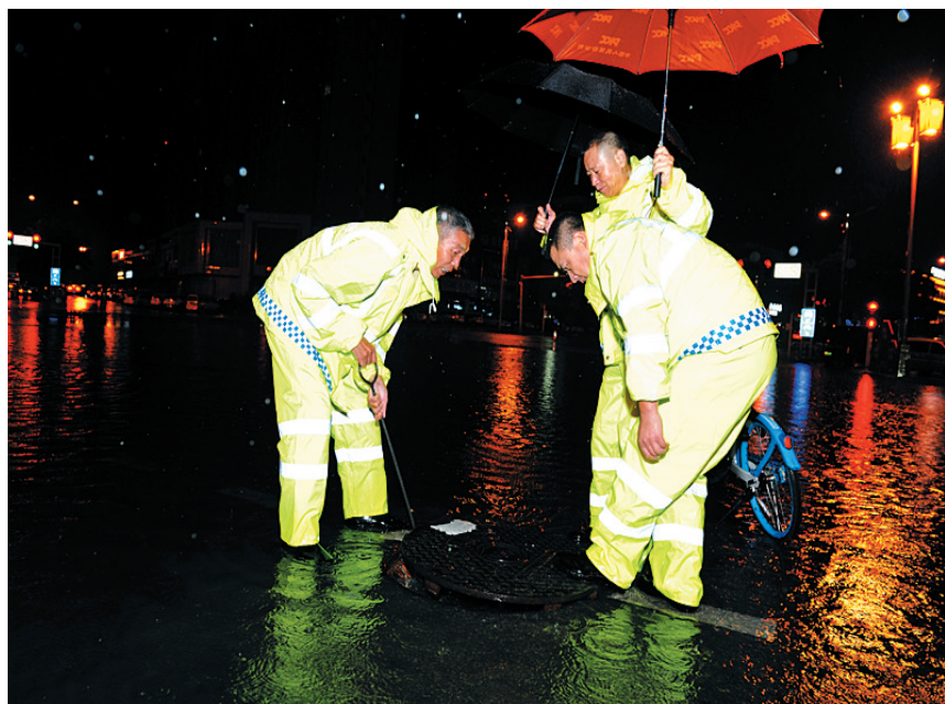
南环路金牛岗道管所工作人员闭合排水完毕的污水井盖 本报记者 于宏 摄
