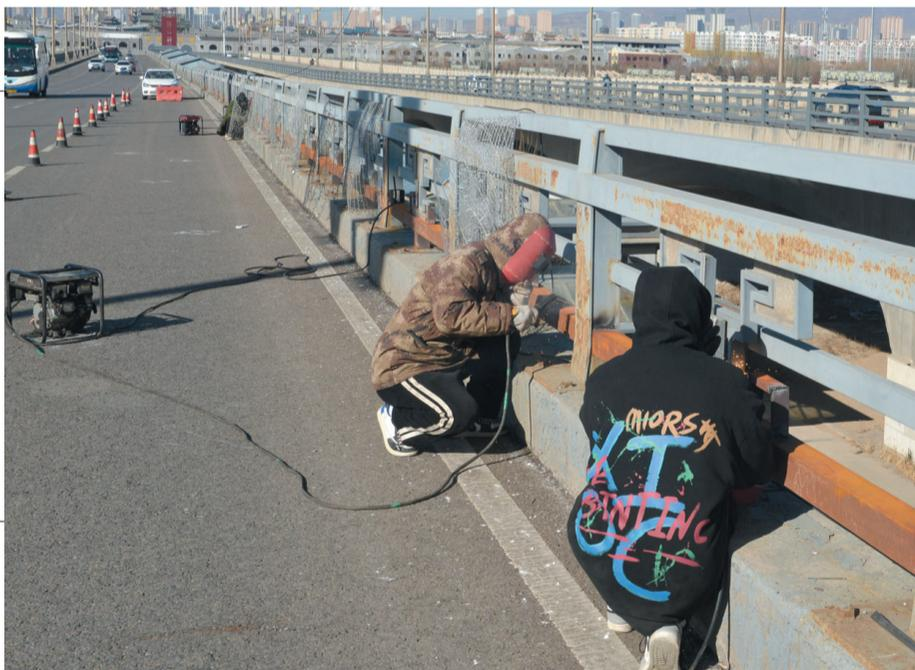
为保障市民安全出行,提升城市功能品质,连日来,市城市管理局桥涵设施服务所相继对北都桥、兴云桥等大桥上的安全防护护栏开展维修保养作业,消除桥梁病害和安全隐患。
