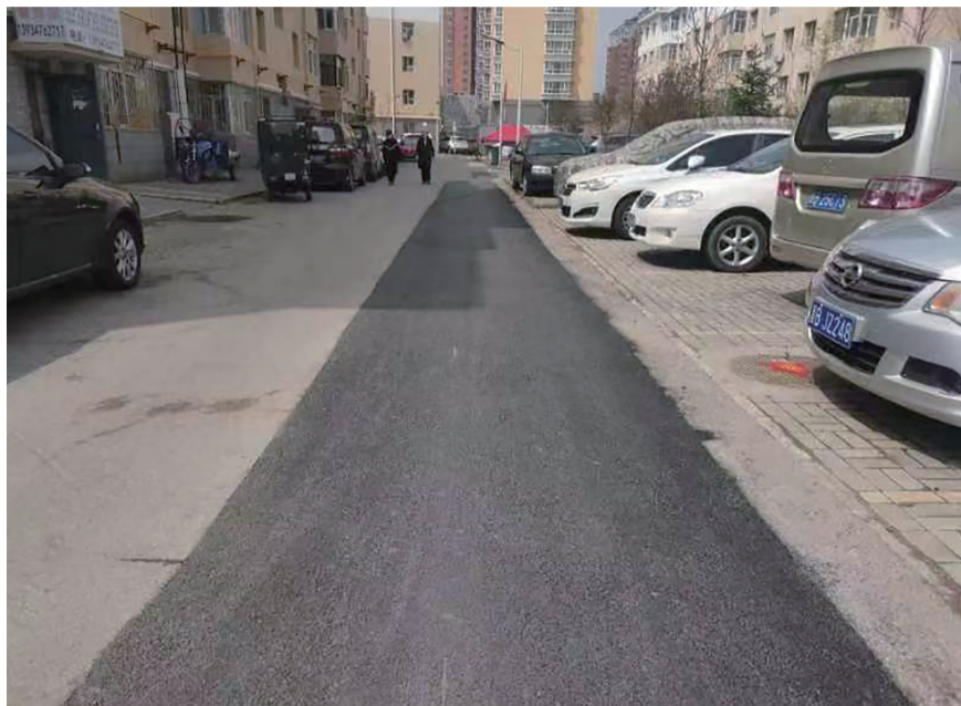
振兴街南院小区路面平整了 龙中华 摄
