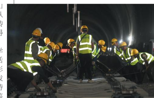
5月22日，中铁一局建设者在金甬铁路楼胜隧道内进行铺轨作业。
