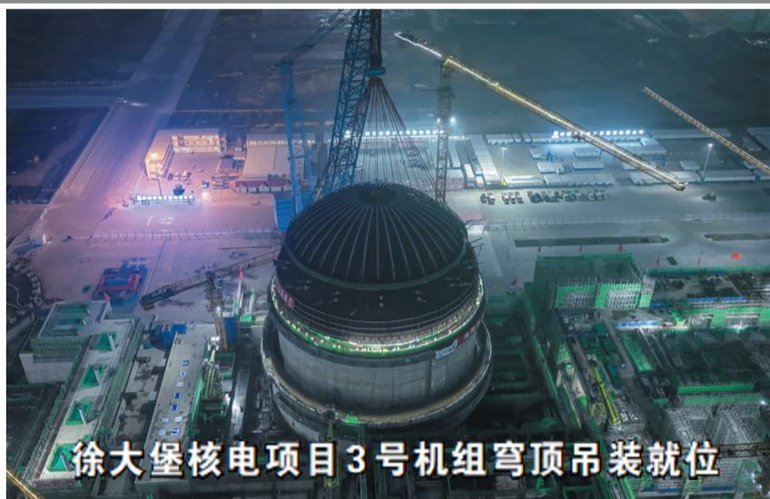
徐大堡核电项目3号机组穹顶吊装就位
