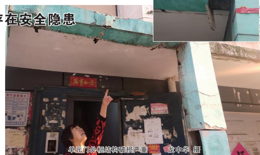
构存在险情。有的严重变形，有的残缺不全，还有的上面吊着一些水泥块，随时可能掉落。
