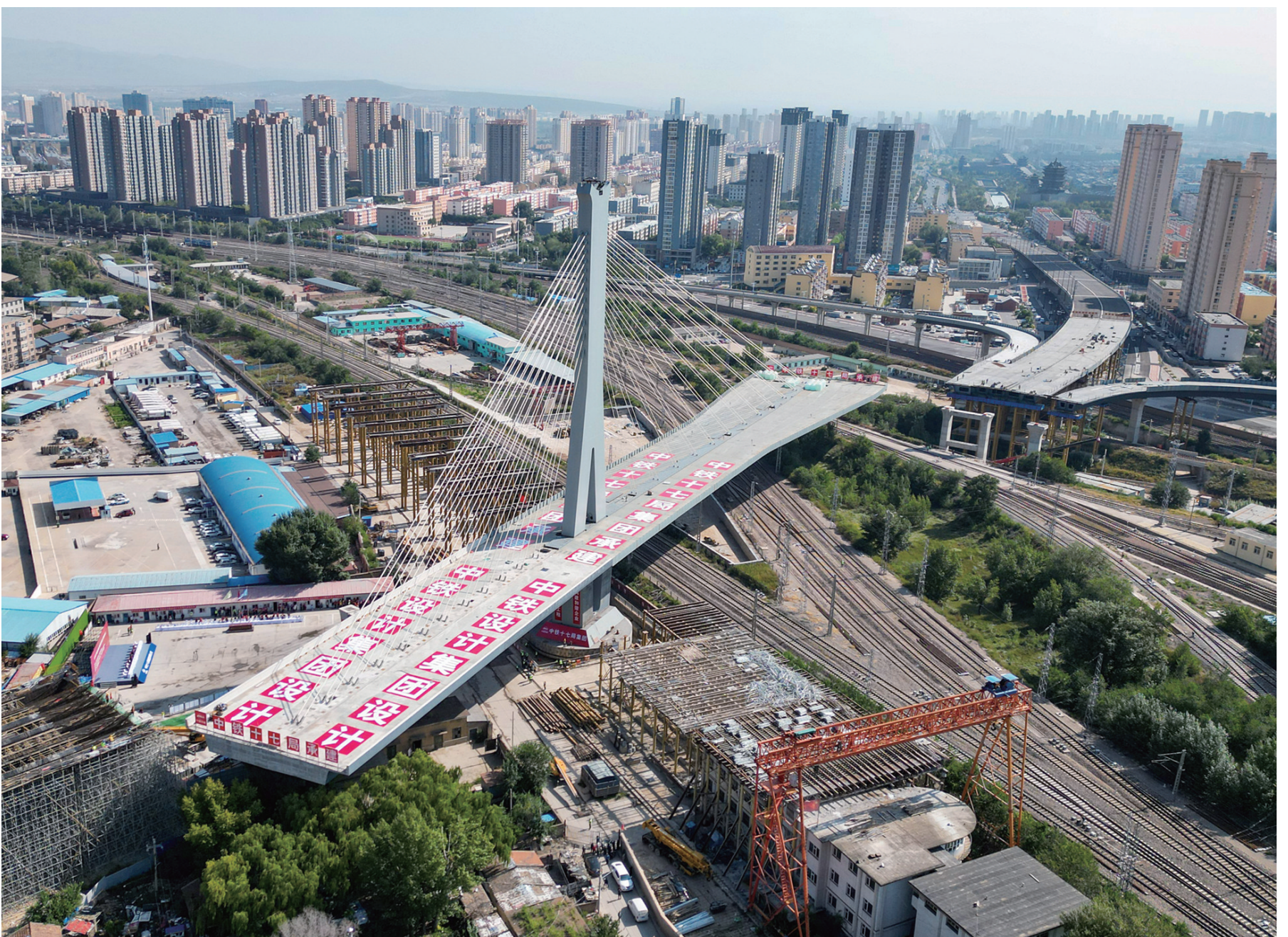
平城街西延跨铁路桥转体施工现场
