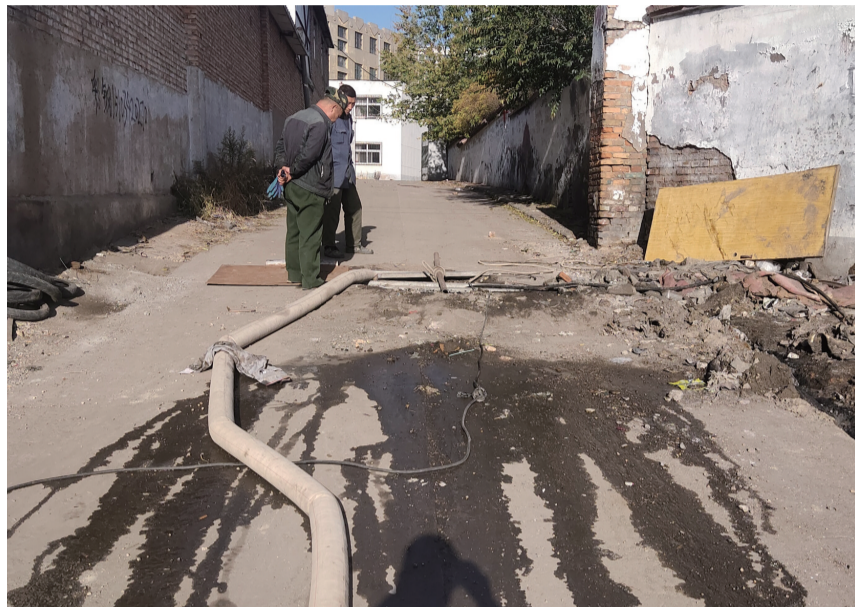
工作人员正在抽污水井内的污水 龙中华 摄
