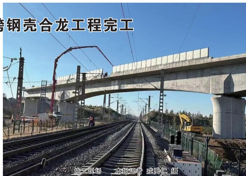
施工的低净空小限界的限制条件下，实现了钢壳快速合龙拼装施工，并选定在气温偏低、温差较小的时间段进行混凝土浇筑，保证各项控制指标符合规范要求。
