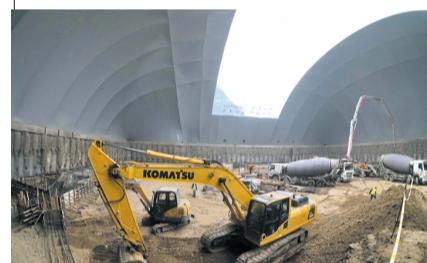
11月17日,工人在“基坑气膜”内工作。近日,北京西城区广外街道三统碑综合大厦项目施工工地上空出现了一个巨型银色“大气球”,总覆盖面积可达4240平方米。这个巨型“大气球”是施工工地安装的大跨度、智能化、创新性的“基坑气膜”,通过气膜内外压力差形成球形建筑,隔绝施工噪音、降低粉尘外溢,同时提高冬季施工环境温度。
