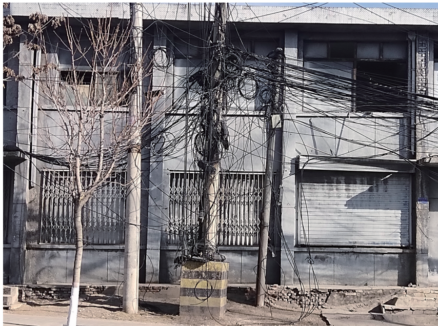
线杆上线缆、线头在半空垂吊
