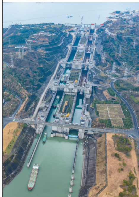
2月21日,三峡北线船闸进行检修施工(无人机照片)。新华社发
